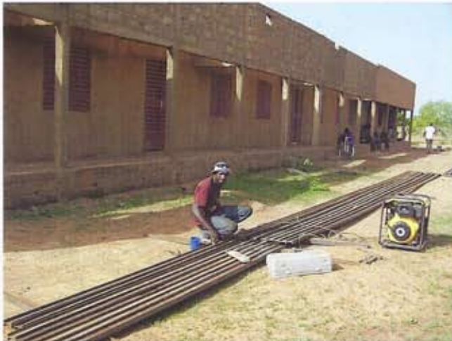
Das Schulgebäude – der rechte Teil wird gerade fertig gestellt
